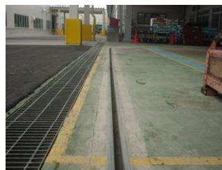
下部の溝部分
